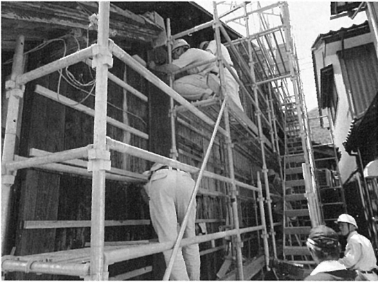
町家の外壁板張り
