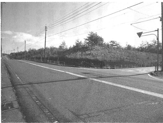
長いこと放置されてきた高森台県有地。巨大な斜面（法面）が目に飛び込んでくる
