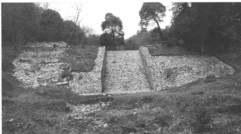
写真上) 7番砂留 整備後の砂留全体の規模が分かる 写真左) 9番砂留 豪雨後の状況 土砂の流出を防ぎ水だけ通す構造
