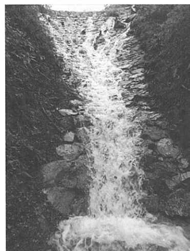
写真上) 7番砂留 整備後の砂留全体の規模が分かる 写真左) 9番砂留 豪雨後の状況 土砂の流出を防ぎ水だけ通す構造
