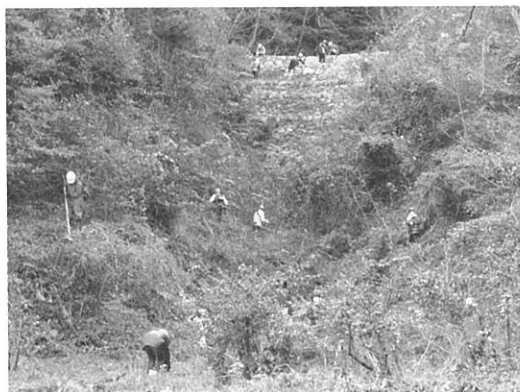
14 番砂留 1年経過するとこれだけ木々が茂る
