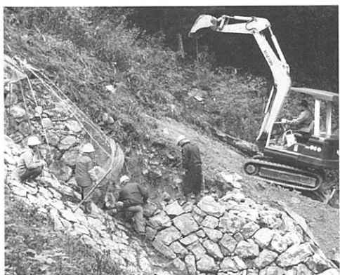
7番砂留 崩落した石組みの修復作業
