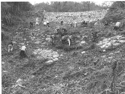
10 番砂留 整備作業風景
