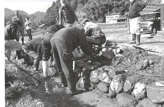
希少生物の棲む、水路の石垣の補修 平和堂財団環境保全活動助成事業「夏原グラント」助成事業
