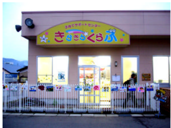
図1 「きらきらくらぶ」の建物
